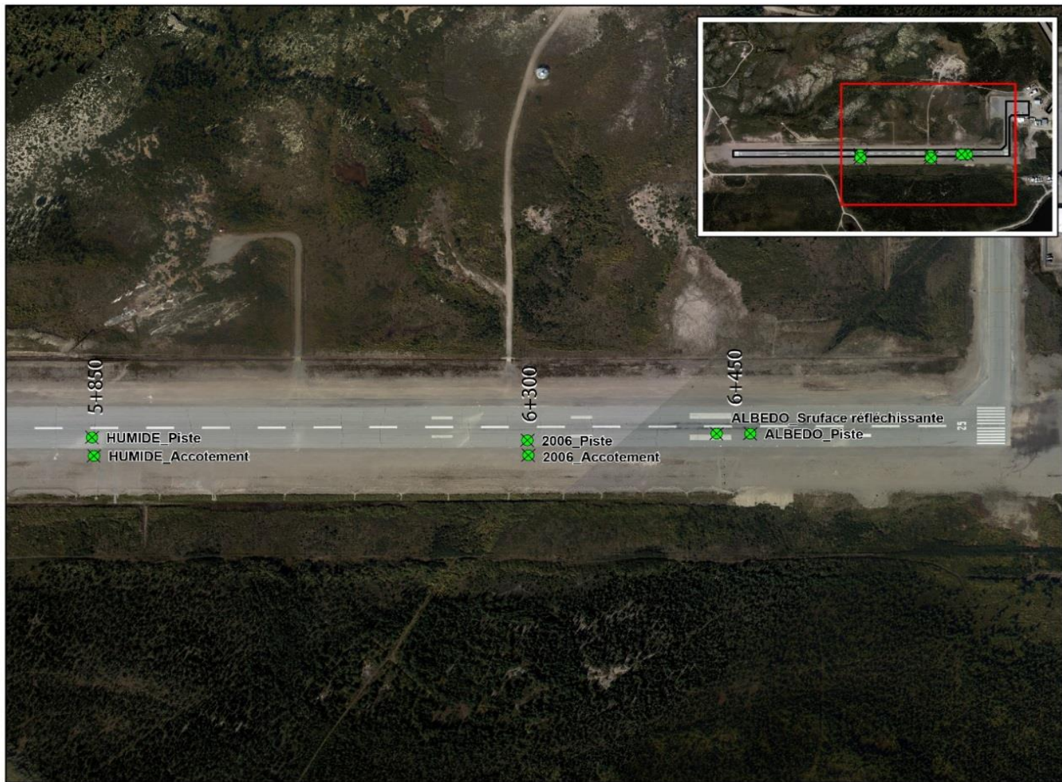
Localisation des câbles à thermistances
